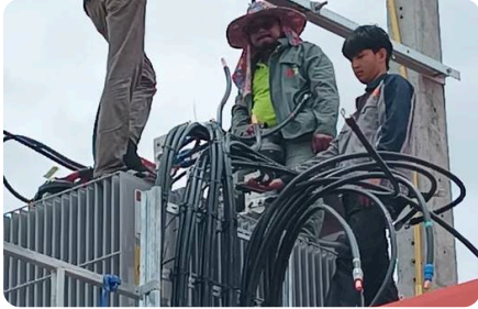
ติดตั้งหม้อแปลงไฟฟ้า 2000 kVA
