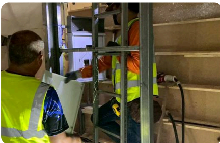
ติดตั้งอุปกรณ์ไฟฟ้าในโครงบุก
