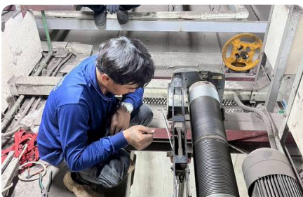
ตรวจสอบชุดขับเคลื่อนและดรัมสลิง
