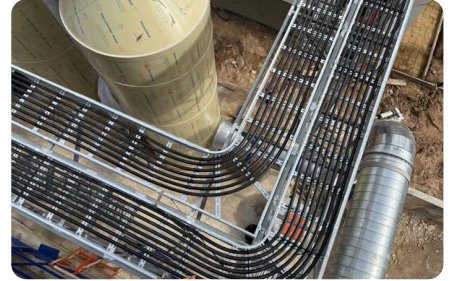
เดินสายไฟบนรางเคเบิล
