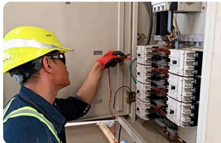
วัดค่าทางไฟฟ้าในตู้ควบคุม
