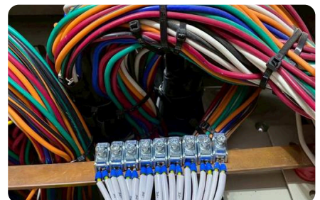
จัดสายและติดเบอร์สาย
