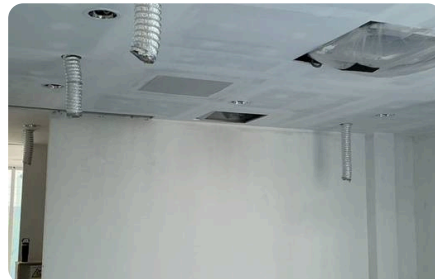
เดินท่อลมไปทุกห้องก่อนปิดฝ้า
