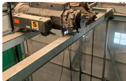
ทำงานบนโครงลิฟต์บรรทุก
